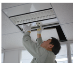
スプリンクラー設置工事中
